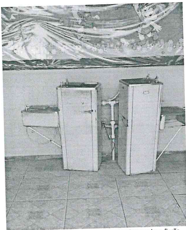
21. Reforma elétrica – reparos em pontos de tomadas e fiação.
